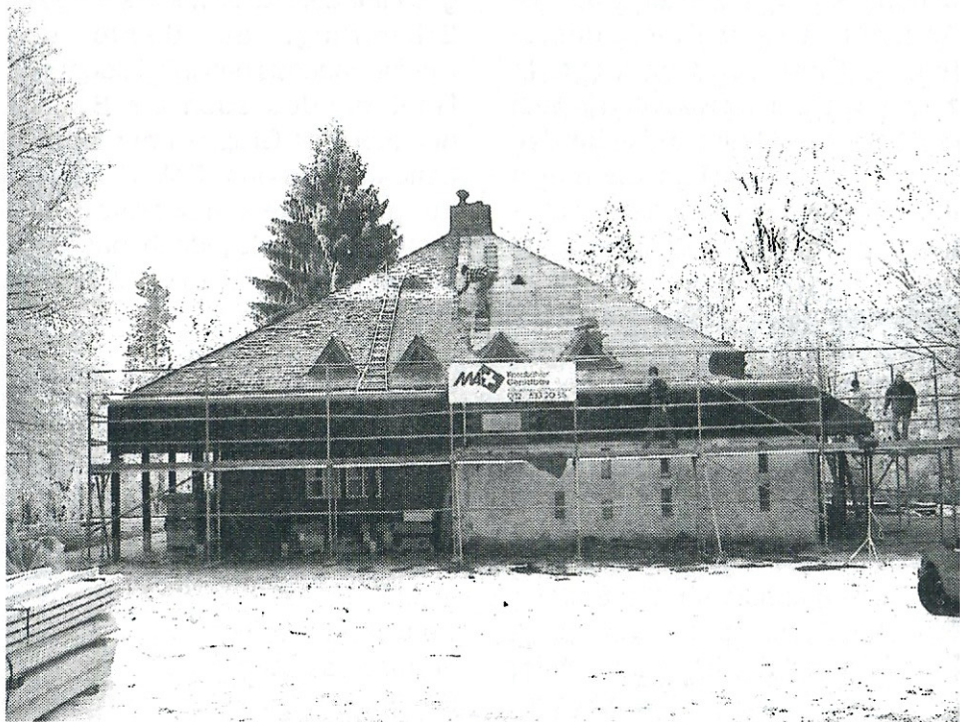
Dachsanieierung im Winter 2002
