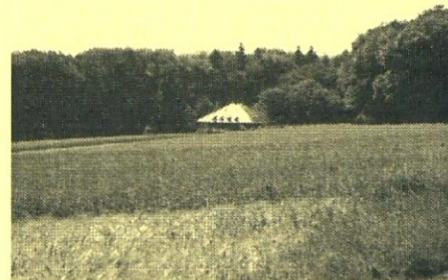
Ansicht von der Zufahrtstrasse Herrenmatt
