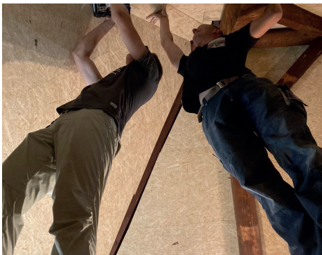
Das Archiv im Umbau
