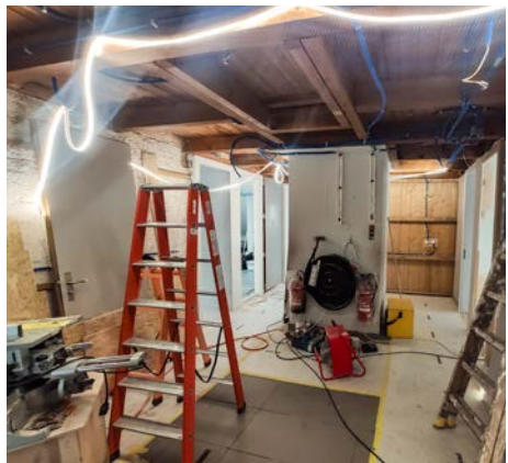
2022, Baustelle im Obergeschoss
